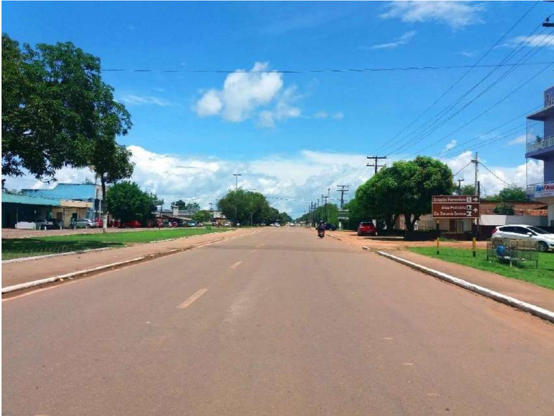
Figura 93 – Principal acesso rodoviário ao Porto de Santana Fonte: Imagem fornecida pela CDSA (2018).
