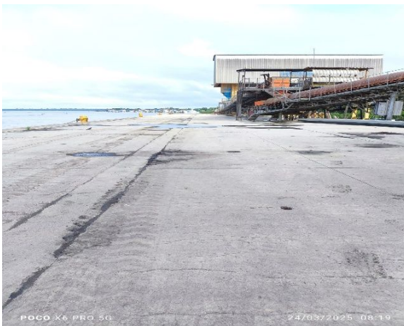
Reparo do Pier 02 (Com uso de Graut)
