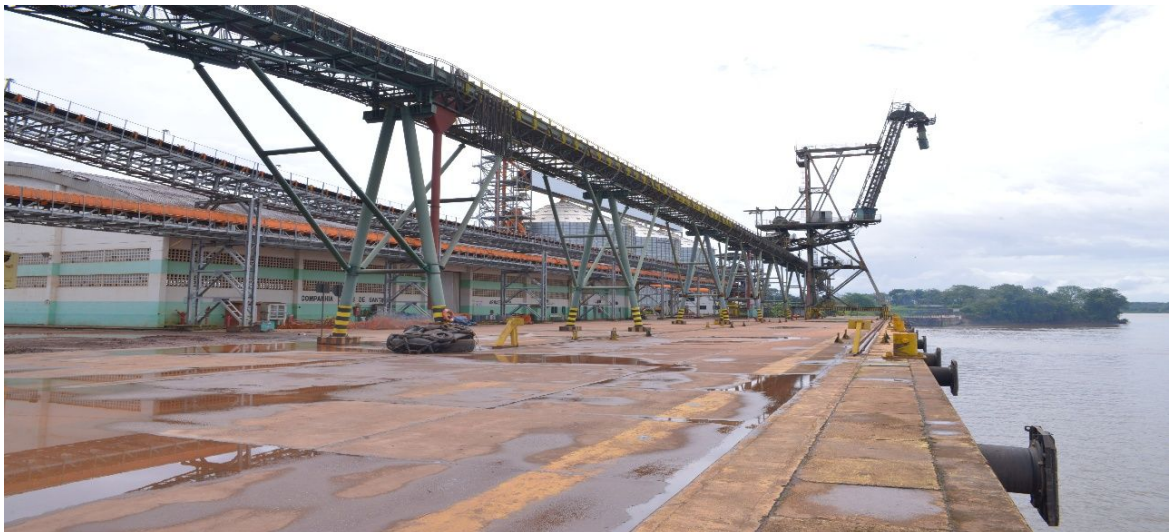
Área do Pier 02 (Dilatação das placas para limpeza e aplicação de Mastique)
