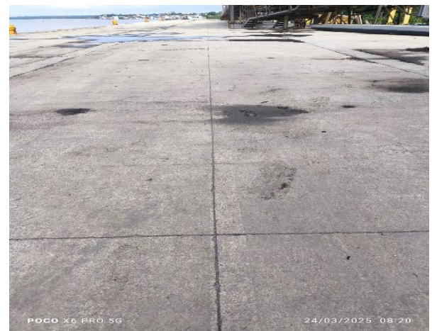
Área do Pier 02 (Dilatação das placas para limpeza e aplicação de Mastique)
