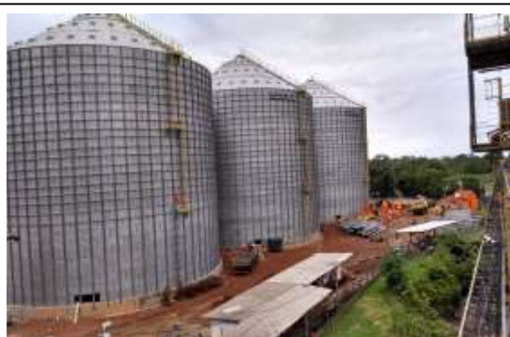
Conclusão da montagem dos silos
