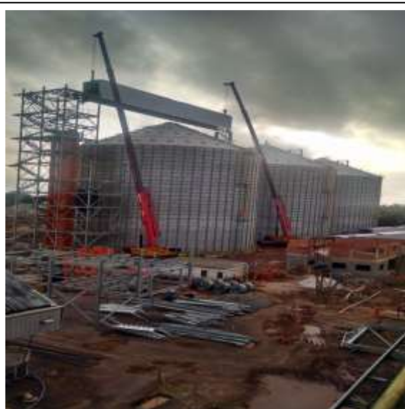
Montagem das correias transportadoras
