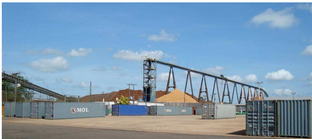
Figura 1.8 – Pátio de Contêineres
